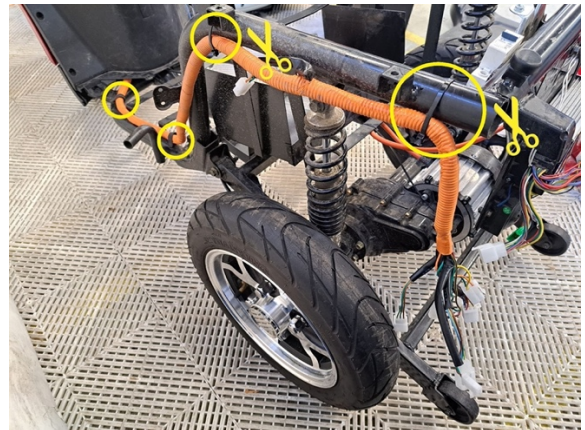
Katkaise johtosarjaa kiinni pitävät nippusiteet. (sivuleikurit). Avaa johtosarjaa kiinni pitävät metalliset lipareet.
